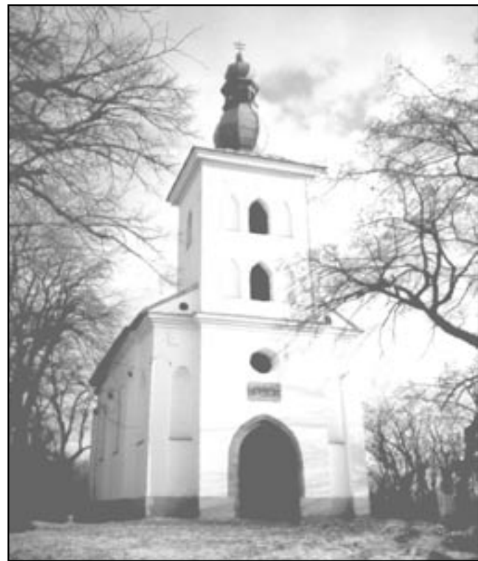
Věž a vstup do kaple sv. Jakuba
