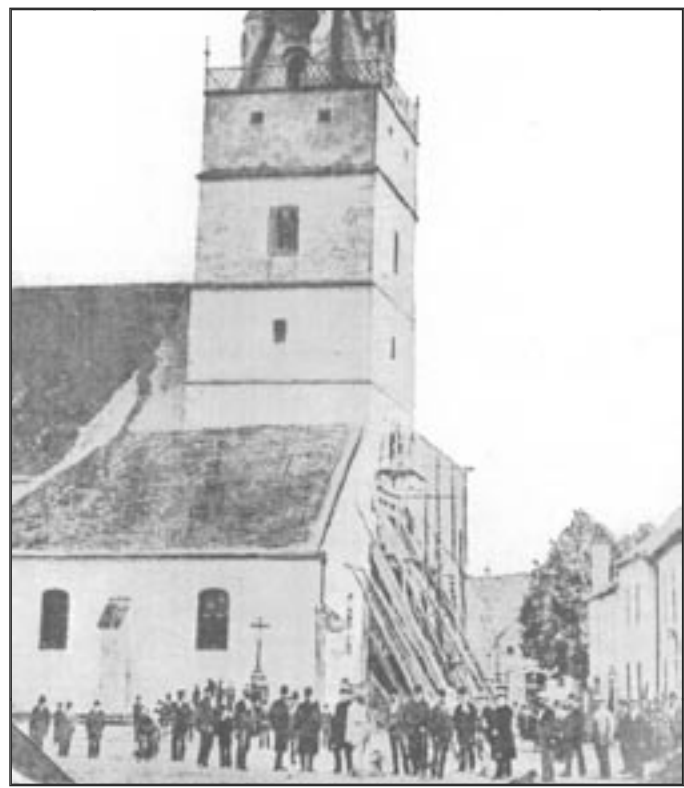
Poděpění sesutím hrozící kostelní věže v Ivančicích v roce 1879
