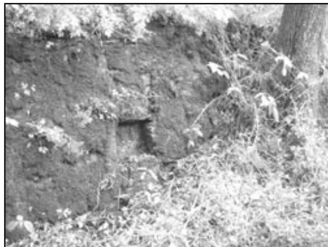
Čtvercový otvor vysekaný do skály sloužil k usazení trámu
