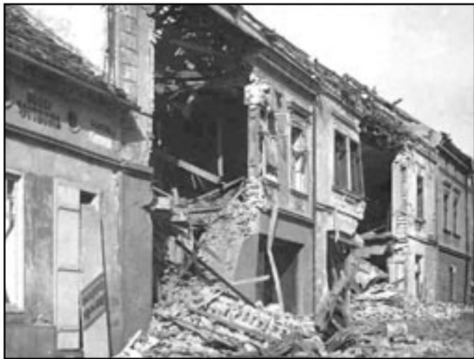
Ulice Zámecká po bombardování, pohled k náměstí TGM
