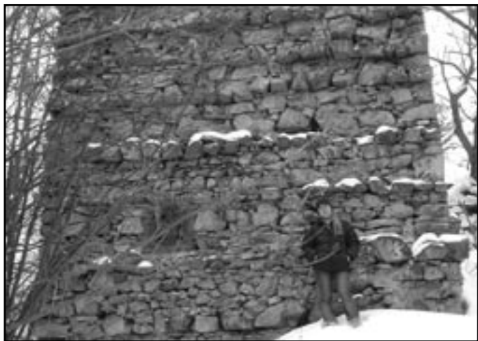
Profil mohutné štítové zdi
