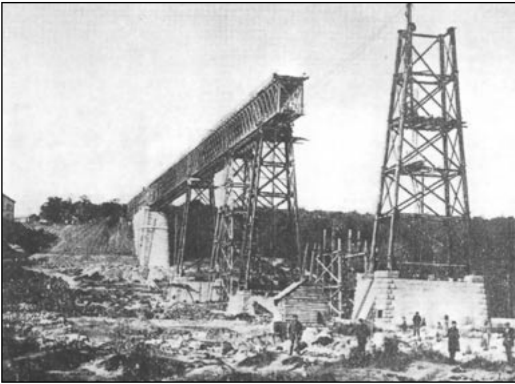
Stavba ivančického viaduktu – r. 1869
