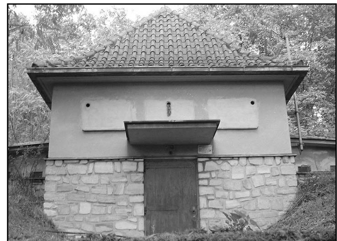
Vodárna na severozápadní ostrožně
