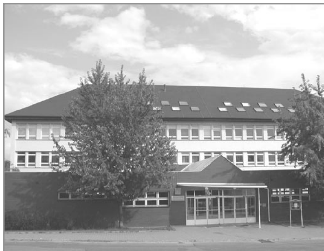
Budova gymnázia v současné době
