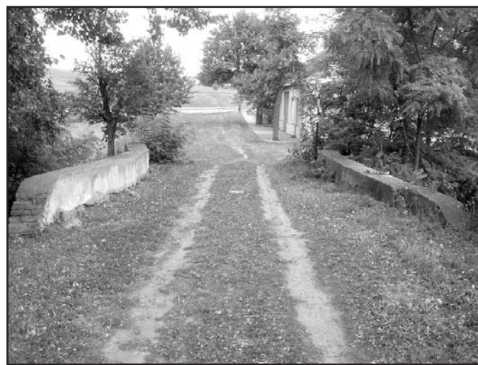
foto 6 - Původní most vozové cesty v Kubšicích
